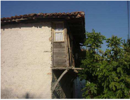
Εικόνα 37. Εγκαταλελειμμένο κτίριο με κλειστό ξύλινο χαγιάτι νότιου προσανατολισμού .
