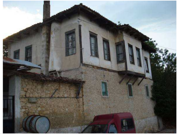
Εικόνα 8. Πετρόκτιστο ισόγειο με ελαφρότερη κατασκευή στον όροφο Διακρίνεται τζάκι στο ισόγειο και σαχισί. ( http://kallithea-dramas.blogspot.com/ )
