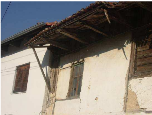
Εικόνα 23. Λεπτομέρεια μεγάλης προεξοχής στέγης για καλύτερη σκίαση (Δυτικός προσανατολισμός). (πηγή: Προσωπικό αρχείο Α.Πασχαλίδου 21/10/2011)
