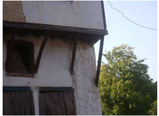
Εικόνα 20. Λεπτομέρεια προεξέχοντος ορόφου για καλύτερο προσανατολισμό. (πηγή: Προσωπικό αρχείο Α.Πασχαλίδου 21/10/2011)
