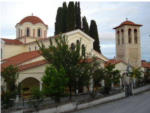
Εικόνα 17. Ο Ναός Αγίου Αθανασίου. Η εκκλησία αναγέρθηκε το 1832 με 1835, διαθέτει γυναικωνίτη και χαγιάτι, ενώ το πυργοειδές καμπαναριό κτίστηκε με πελεκητή πέτρα το 1869. ( http://kallithea-dramas.blogspot.com/ )
