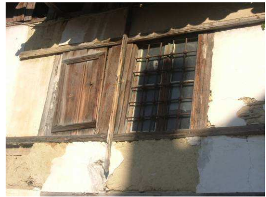
Εικόνα 22. Λεπτομέρεια κουφωμάτων με ξύλινα χωρίς γρίλιες παντζούρια καθώς και δείγμα σιδεριάς για ασφάλεια. (πηγή: Προσωπικό αρχείο Α.Πασχαλίδου 21/10/2011)
