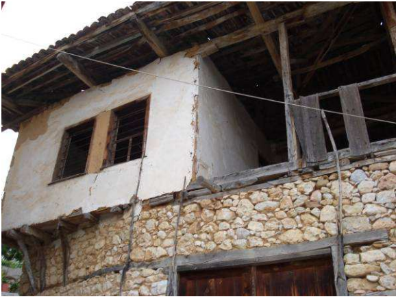
Εικόνα 7. Τα σπίτια είναι κατασκευασμένα από πέτρα για το ισόγειο και από μπαγδατί στον όροφο και βεράντα. Υπάρχει επίσης σαχισί .Διακρίνονται τα ξύλινα δεσίματα στον πετρόκτιστο τοίχο. Η στέγη προεξέχει, είναι ξύλινη με βυζαντινά κεραμίδια ( http://kallithea-dramas.blogspot.com/ )
