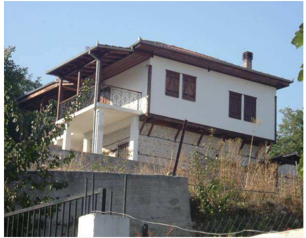
Εικόνα 26. Συντηρημένη κατοικία με μη αρμόζουσες αρχιτεκτονικά προσθήκες .
